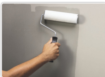
Fase 5 - Dopo almeno 12 ore applicare a rullo (PE15) 15/18 mq/litro Vetro Opaco diluito 30% con acqua
